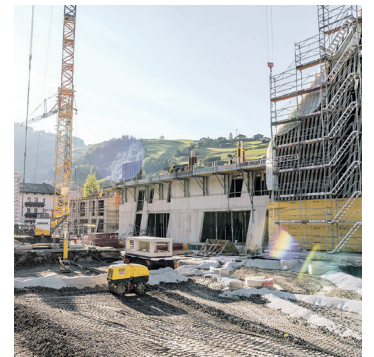
Mit dem Erweiterungsbau wurde schon begonnen...
