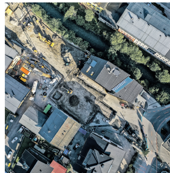
Die Großbaustelle in Kaprun aus der Vogelperspektive...
